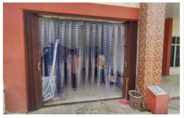
Gambar 3.3 Proses melengkapi tirai plastik antara ruang produksi dengan ruang penjemuran sesudah
